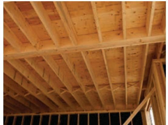
Figure 14. Exemple de structure de bâtiment en **ossature de bois**.
