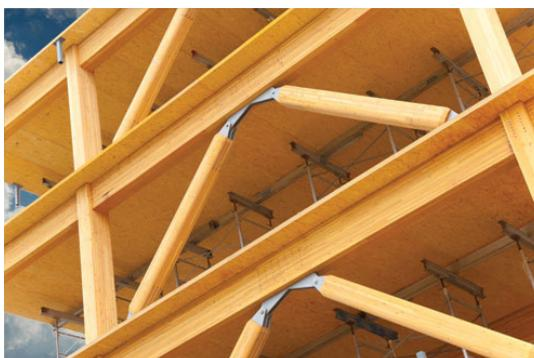
Figure 15. Exemple de structure de bâtiment en **bois lamellé croisé (CLT)**.
